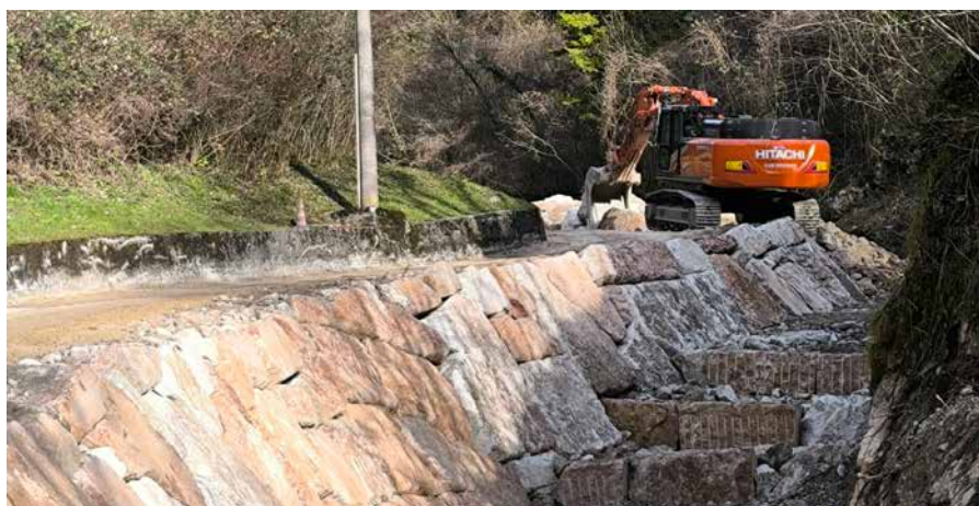
Lavori di difesa spondale lungo il Tegorzino in località Santa Barbara a Schievenin
