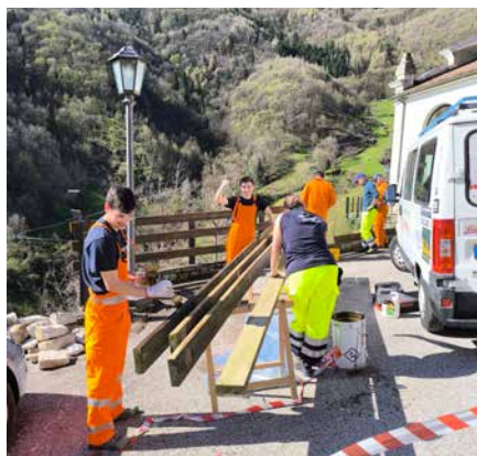
Lavori al piazzale chiesa di Schievenin
